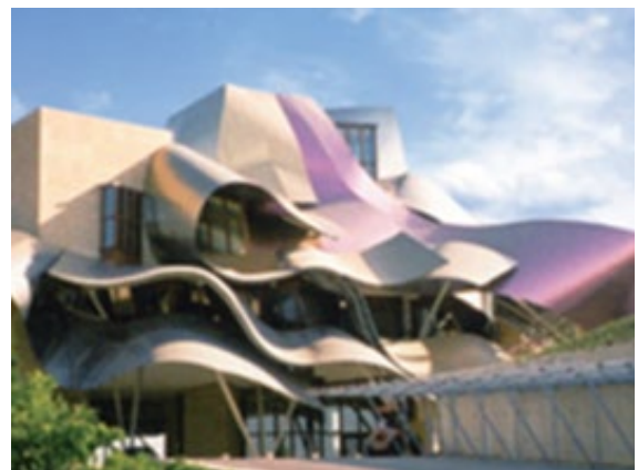
図 1.1 酸化皮膜を有するチタンを用いた建築物 (ホテル・マルケス・ド・リスカル)
