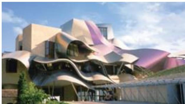
図1 酸化皮膜を有するチタンを用いた建築物
