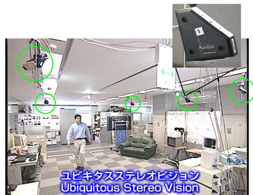
図 6.1 実験室に設置されたユビキタスステレオビジョン(ネットワーク接続された 5 台のステレオカメラを利用)
